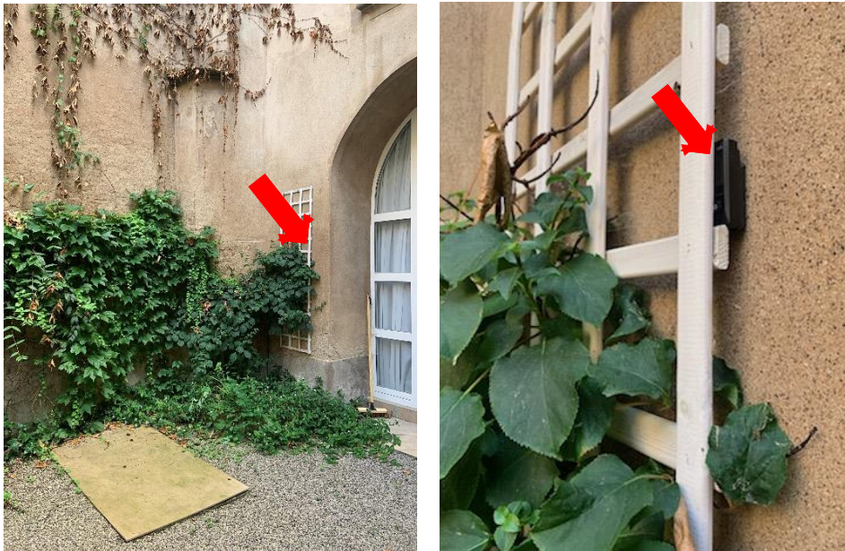
Standort des Sensors Grande Rue ; Google Earth
