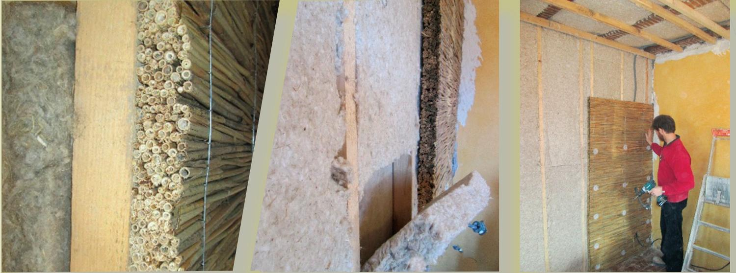
*Dämmung mit Hanfwolle und Schilfrohrplatten.*
