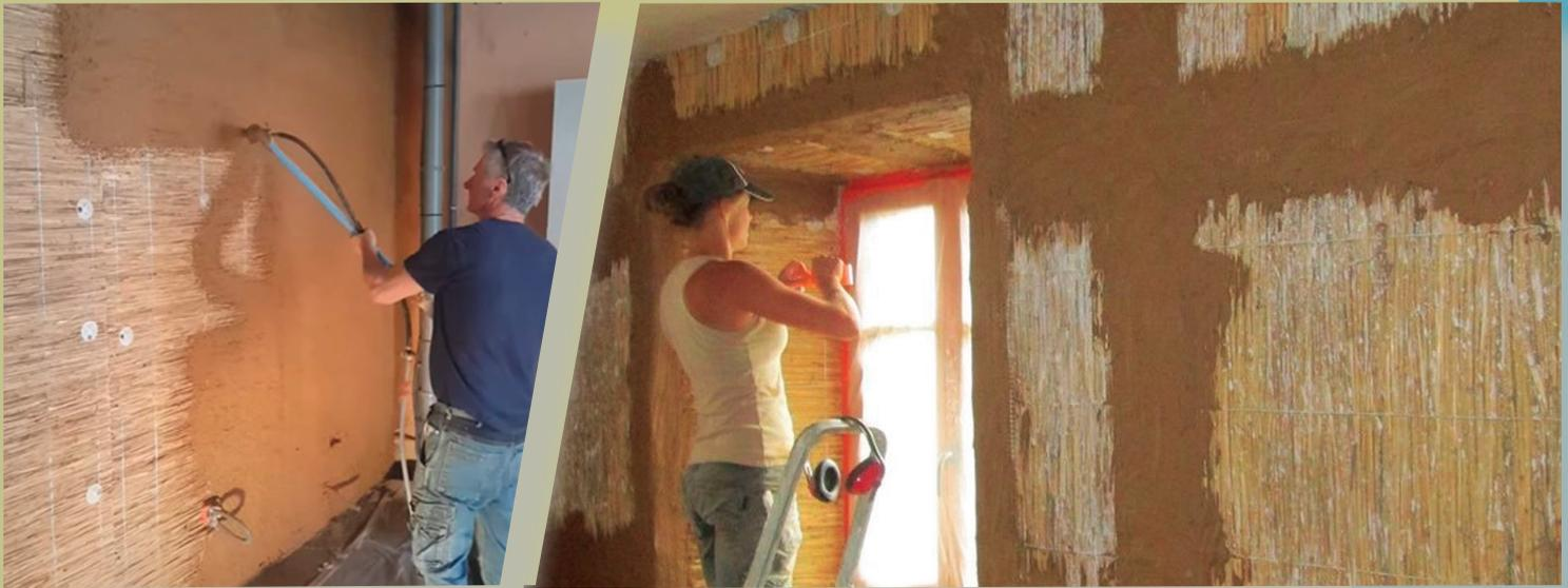
*Aufbringen von Lösslehmputz auf Schilfrohrplatten.*
