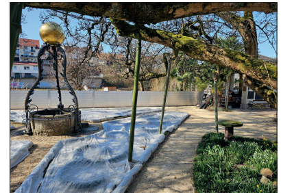
Mobile Hochwasserschutzwände im Katz'schen Garten in Gernsbach
