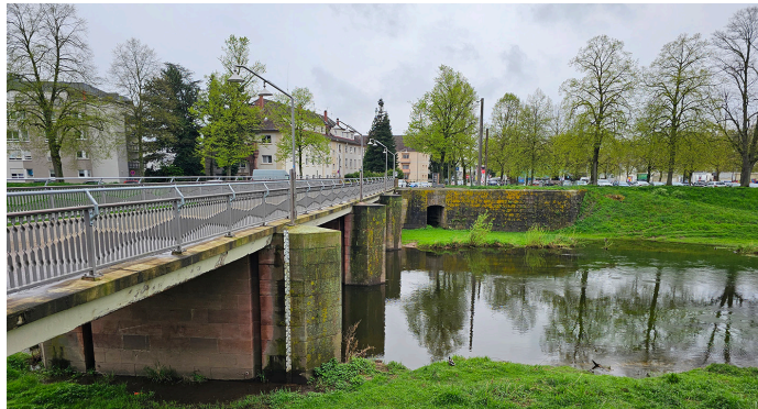
Schließbrücke in Rastatt
