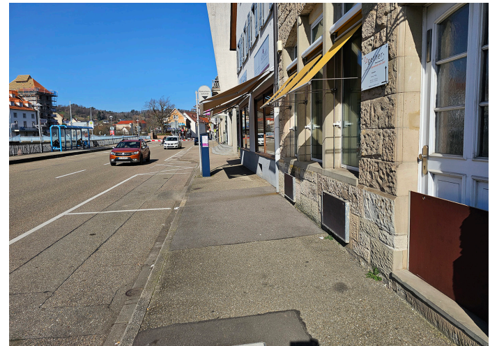
Mobile Paneele vor tiefliegenden Fenstern und Eingängen tragen zum Hochwasserschutz bei
